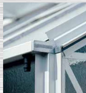
D Isolierverglasung (Stegdoppelplatte)
