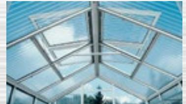
Serienmäßig: Große Dachfenster mit je 1 m<sup>2</sup> Fläche sorgen für beste Belüftung (automatischer Fensteröffner = Zubehör). Schädlingen und Pilzen wird der Nährboden so von vornherein entzogen.
