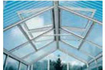
Serienmäßig: Große Dachfenster mit je 1 m<sup>2</sup> Fläche sorgen für beste Belüftung (automatischer Fensteröffner = Zubehör). Schädlingen und Pilzen wird der Nährboden so von vornherein entzogen.
