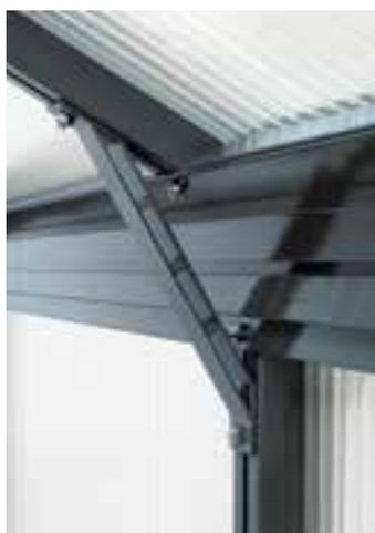
**Firstunterzüge** und **hochfeste Seitenverstärkungen** perfektionieren die Widerstandsfähigkeit gegen Schnee- und Windlasten.
